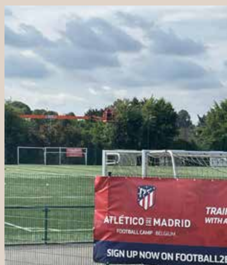
Placement des filets pare-balls à Lausprelle.
