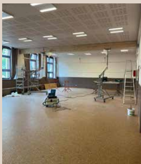
Placement d'une poutrelle pour support rideau à la salle des Combattants.
