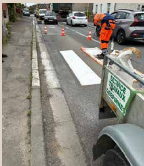
Remise en peinture du passage piétons à la rue de Villers.
