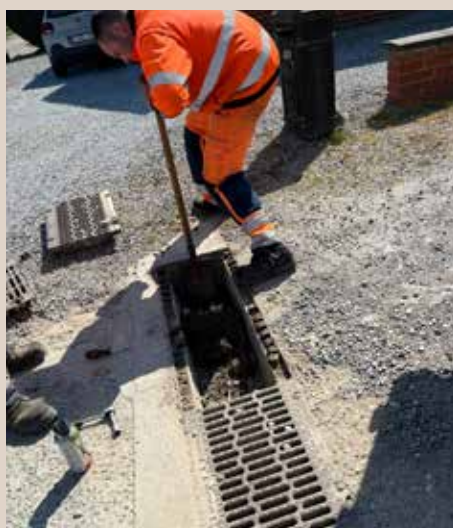
Entretien des grilles de caniveau, rue de Villers.
