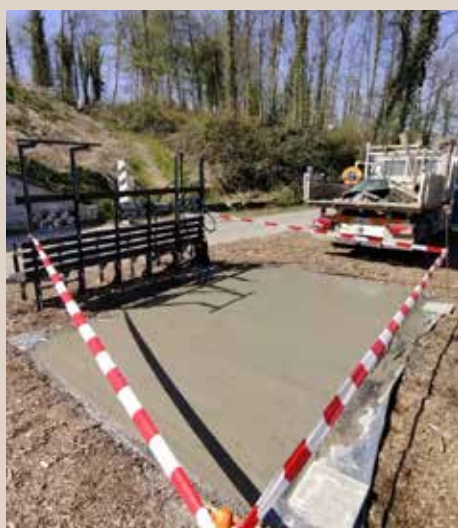
Réalisation d'une dalle pour le banc multisports situé sur le Ravel.
