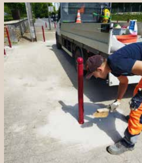
Remplacement des bollards à l'entrée du parc st Adrien.
