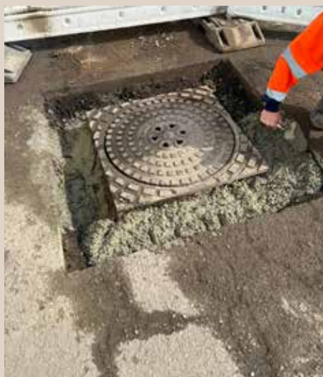
Réparation d'une chambre de visite à la rue du Maka.
