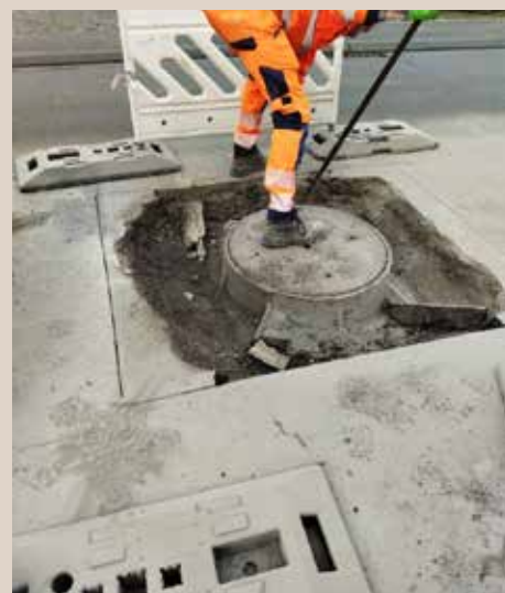
Réparation du contour d'une chambre de visite dont l'encadrement s'était affaissé à la rue de Presles.
