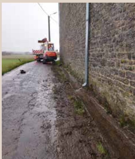
Nettoyage des filets d'eau rue de l'Église le long de la ferme et des champs.
