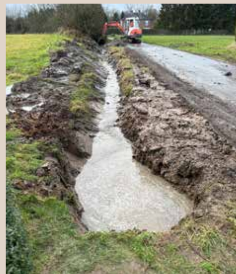
Recréation du fossé et dégagement de la grille existante à la rue Bois du Champs.
