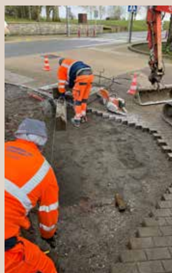
Modification du parterre à la place des Combattants.
