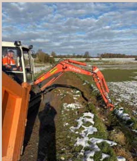
Curage et re profilage de fossés.
