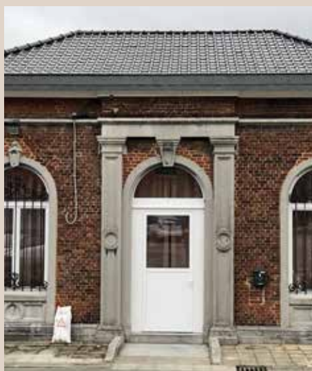
Remplacement des châssis et de la porte d'entrée du local de la musique à Acoz.
