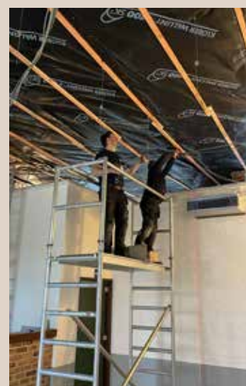
Travaux d'isolation à la salle d'Acoz.
