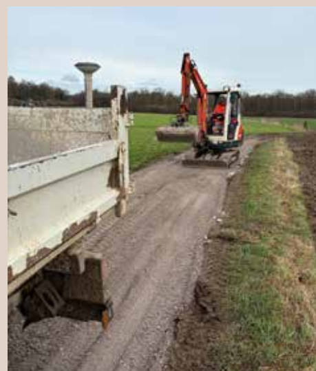
Aménagement du chemin agricole rue de Presles.
