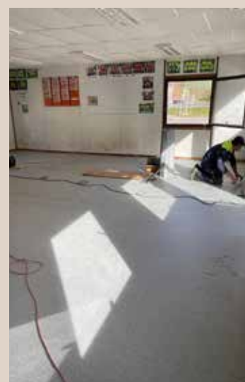
Pose vinyle et plinthes sur le nouveau plancher du ballodrome d'Acoz.
