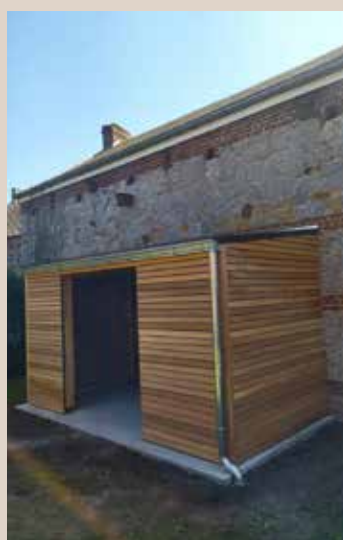
Construction d'un abri vélos à l'école de Gougnyes.
