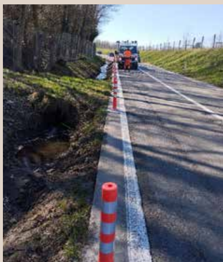
Mise en place de bollards pour sécuriser le fossé à la rue de la Blanche Borne à Loverval.
