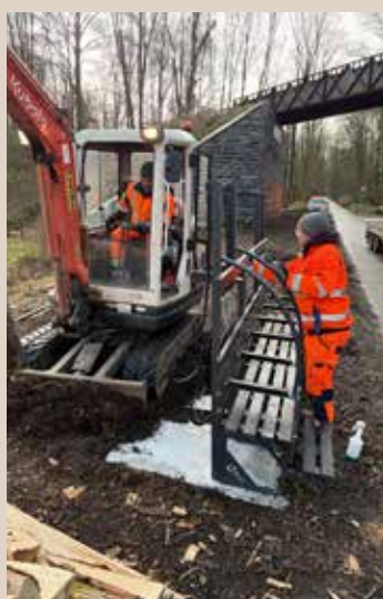
Pose d'un banc multisport sur le Ravel.
