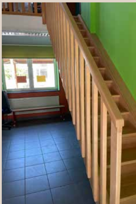
Pose d'un nouvel escalier à l'école de Gougnyes.
