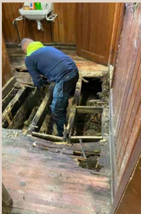
Remplacement du plancher du chalet de Fro-miée.
