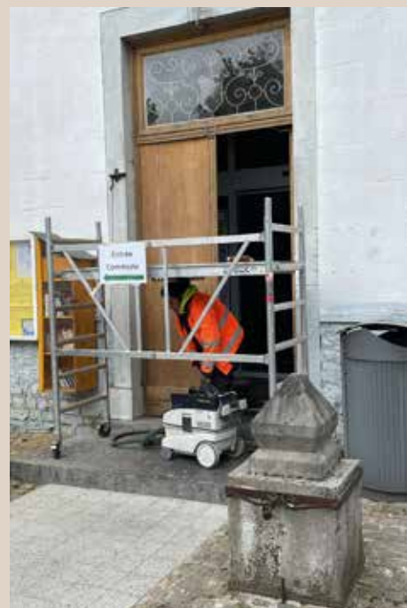
Rénovation de la porte d'entrée de la maison communale.
