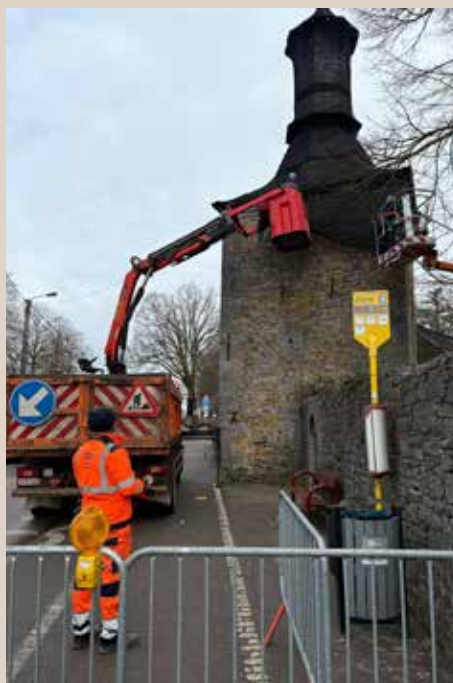
Pose d'un filet de protection sur la tour de la maison communale.
