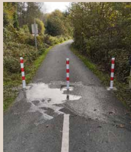
Uniformisation des bollards sur le Ravel.
