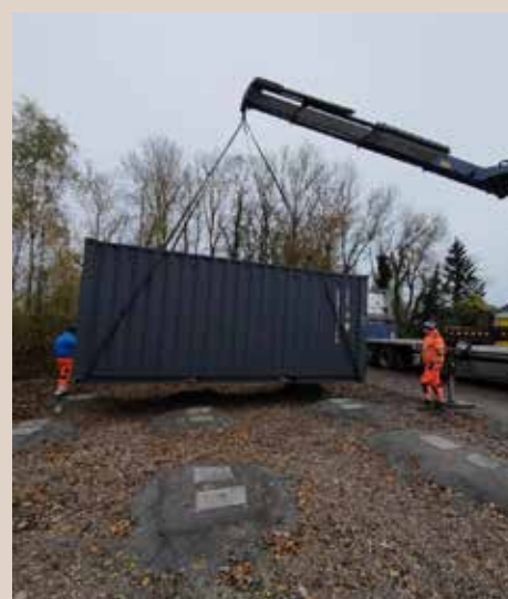
Préparation de plots et mis en place de conteneurs pour stockages divers.
