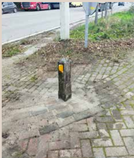
Réparation des bollards le long de la N5 à Loverval.
