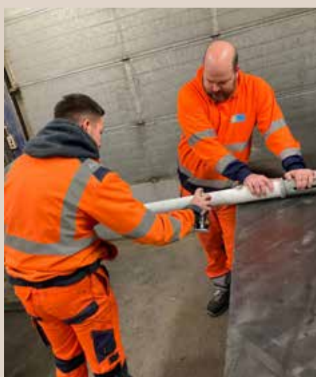
Rénovation de bollards usés.
