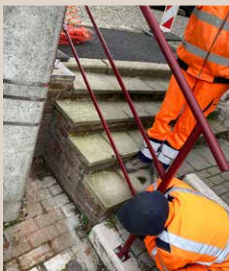
Installation d'une main courante à la place de la Halle - Gerpinnes-Centre.
