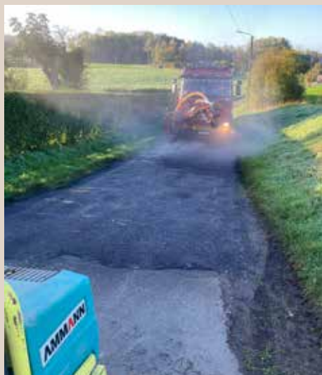
Réfection de nids de poule à l'aide d'un camion à projection de tarmacà chaud.
