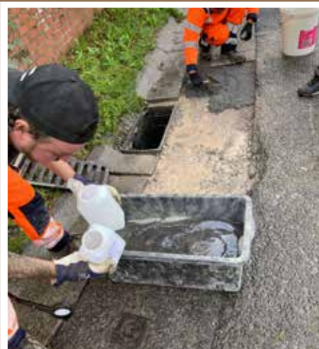
Réparation d'un bord de filet d'eau très sollicité au carrefour de la Blanche Borne et de la rue de la Brasserie, réalisée à l'aide d'une nouvelle résine en phase de test. Cette résine est testée pour des réparations urgentes dans des zones humides.
