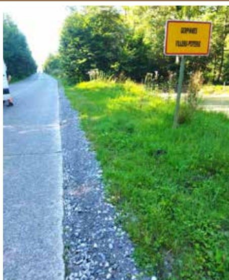
Empierrement des accotements à l'entrée du bois rue de Presles - Villers-Poterie.
