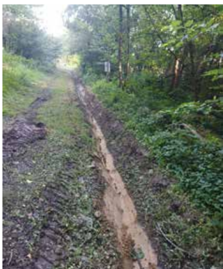
Fauchage et curage du fossé provenant du bois à la Blanche Borne pour éviter tout soucis d'inondation.
