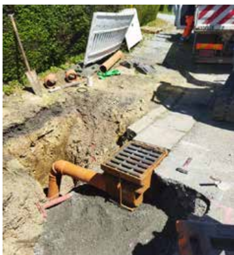
Remise en état d'un raccordement d'avaloir à la suite d'un affaissement en voirie - Allée des Croisades.
