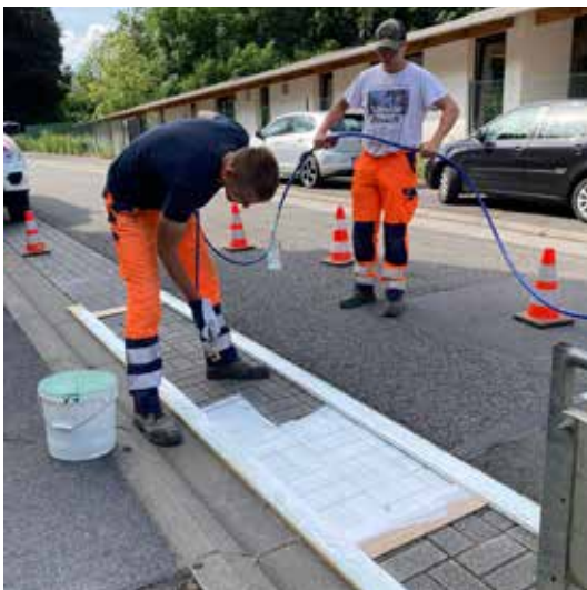
Réalisation d'un passage piéton, rue de la Brasserie, devant la crèche de Loverval.
