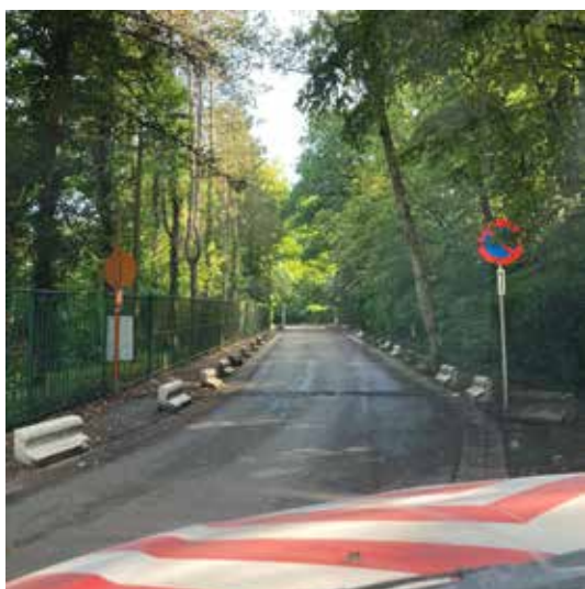
Mise en place de bordures chasse roues et de signalisation afin de faciliter la circulation aux abords de la piscine de Loverval.
