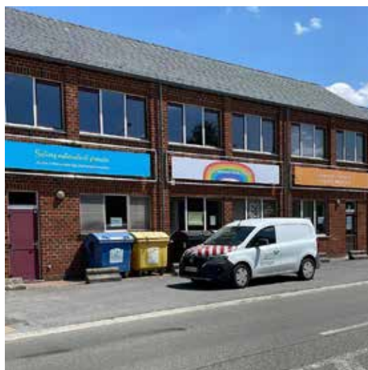
Placement de bâches à l'école des Flaches.
