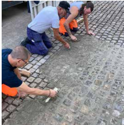
Réfection des joints de la zone en pavés devant la maison communale.
