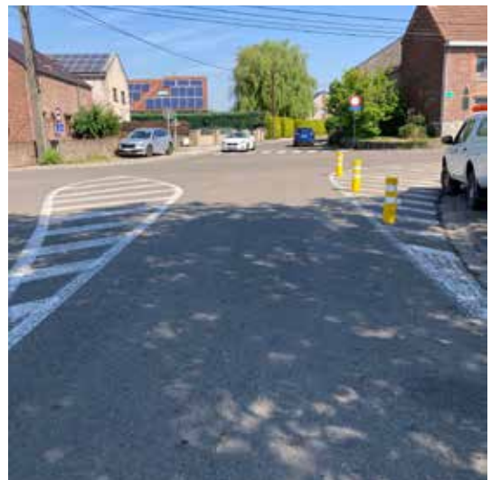
Mise en place de bollards afin de sécuriser les piétons - rue de Bertransart et rue de Tarcienne.
