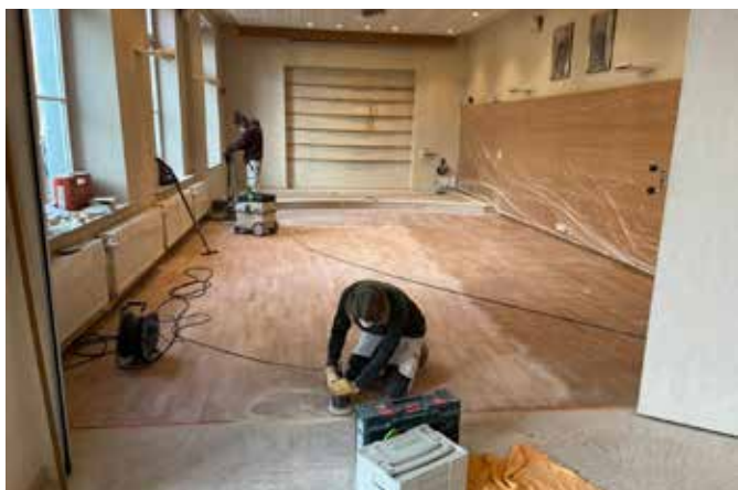
Travaux de rénovation à la salle du conseil.
