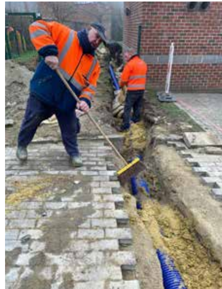
Réparation d'une fuite au collecteur de chauffage à l'école de Gougnyes.
