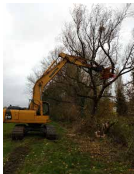
Début du chantier de la Blanchisserie, taille de la végétation.
