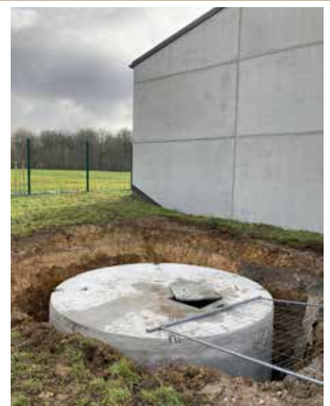
Pose d'une citerne d'eau de pluie au service travaux.
