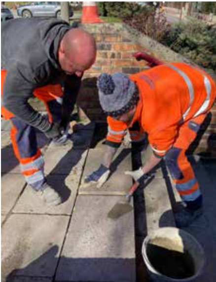
Réparation des marches à la place des Libertés.
