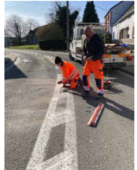
Mise en place de délimiteurs de bandes à la rue Van Brusselt.
