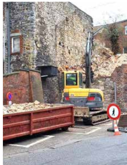
Démolition d'une remise à l'avenue Astrid.
