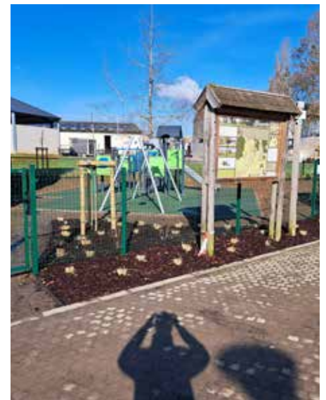
Travaux aire de jeux de Lausprelle.
