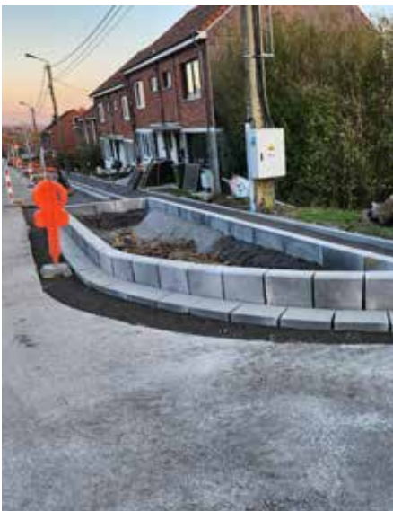
Travaux de rénovation des trottoirs à la rue de la Raguette.
