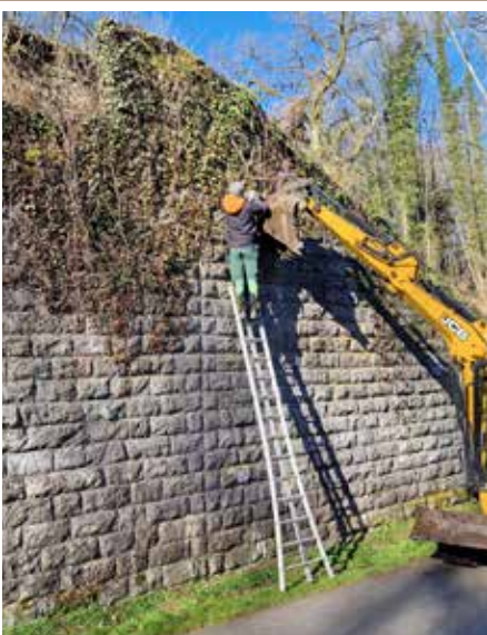
Travaux de dessouchage pour le futur Ravel.
