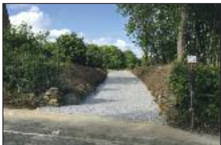
Aménagement d'une rampe d'accès à la rue du Château d'En Bas - Gerpinnes
