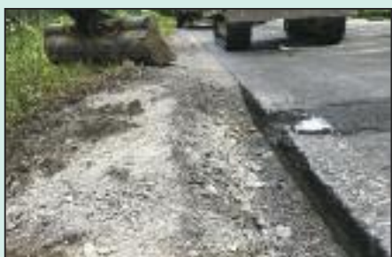
Réparation des ornières à la rue de la Blanche Borne - Loverval
