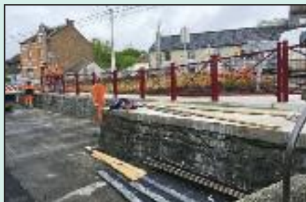
Aménagement d'un trottoir sécurisé à Gougnyes
