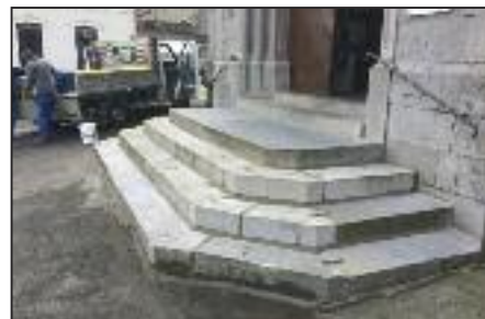
Réparation des marches de l'église de Villers-Poterie
