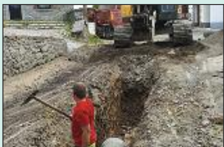
Travaux d'égouttage rue de l'Astia - Hymiee
