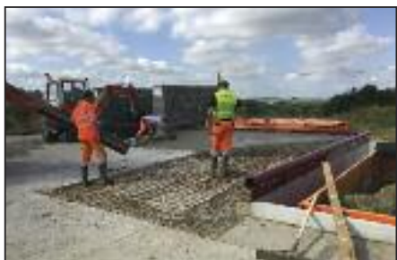
Aménagement d'une rampe d'accès au service travaux - Gerpinnes
