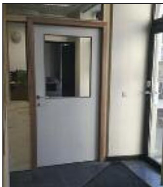
Construction d'un sas d'entrée dans le bâtiment du GAL.
