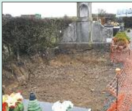
Aménagement d'une aire de dispersion.
