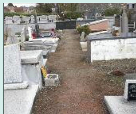
Enlèvement des graviers à Hymiee pour végétalisation des allées des cimetières.
