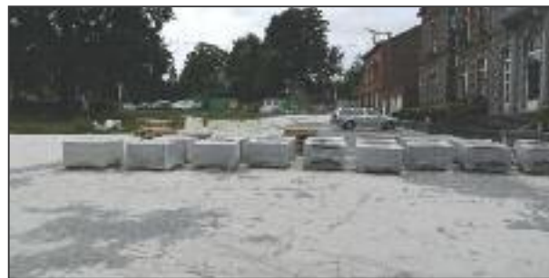
Poursuite du chantier de l'aménagement de la Place de Gougnyes.
