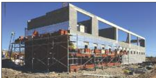
Travaux terrain de foot de Lausprelle : construction de la buvette.
