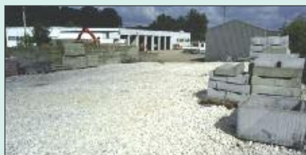
Aménagement d'un espace de stockage au Service travaux.
