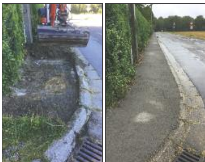
Aménagement d'un trottoir rue de la Ferrée.
