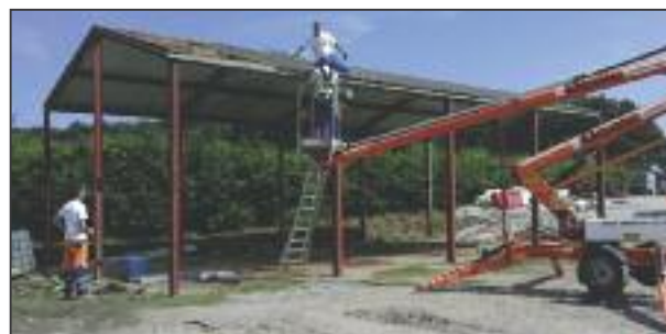
Démontage de l'ancien hangar au Service travaux en prévision du nouvel entrepôt.
