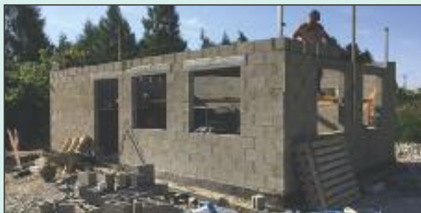
Construction d'un local pour le club « les Archers » par le Service travaux à Joncret.
