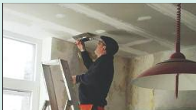
Travaux de rénovation à la Cure de Gerpinnes : installation d'une salle de bain et réalisation de faux plafonds.
