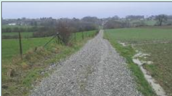
Empierrement du Chemin des Roches entre Joncret et Gerpinnes.
