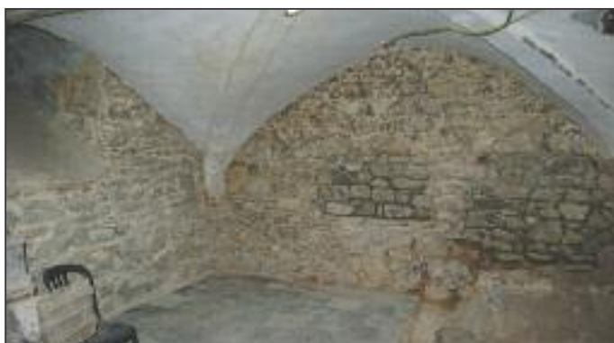
Restauration d'une cave à la Maison communale.
