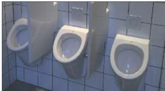
Remplacement sanitaires à la Salle communale de Villers-Poterie.
