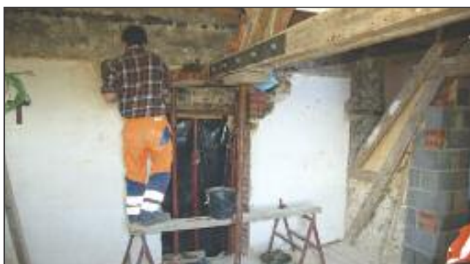
Aménagement d'un grenier en bureau à la Maison communale.
