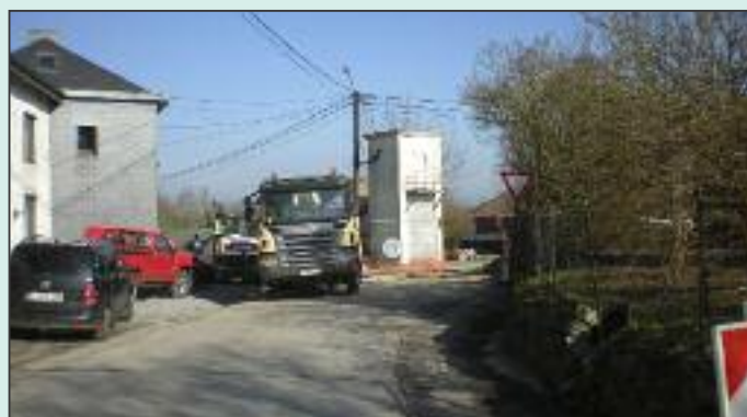
Travaux d'égouttage à la rue de Biesme à Fromiée.
