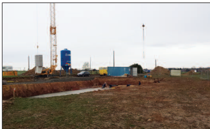
Foot : L'infrastructure footballistique de Lausprelle a débuté ce 1 er mars.
