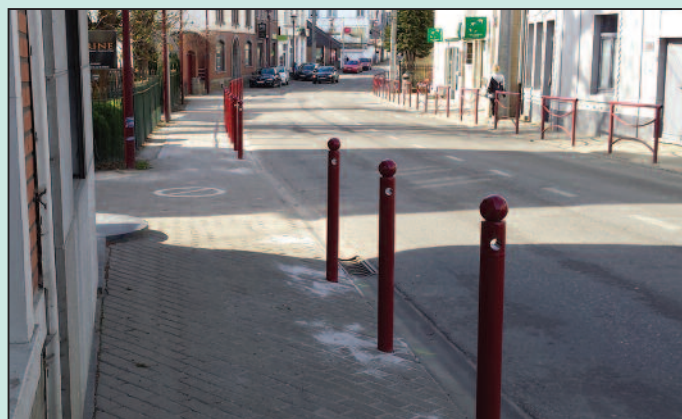
Sécurisation des piétons à l'Avenue Albert 1 e à Gerpennes par la pose de bollards.
