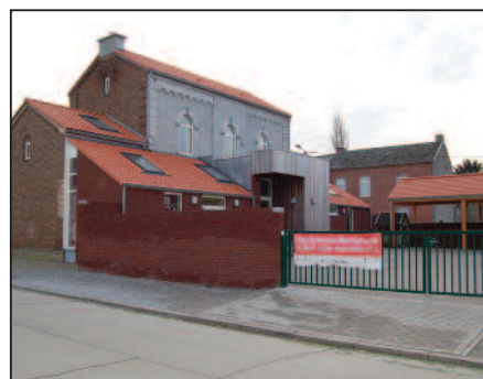
Finalisation des travaux à l'école d'Hymée : subsides 506.0000 € - part communale : 94.172 €
