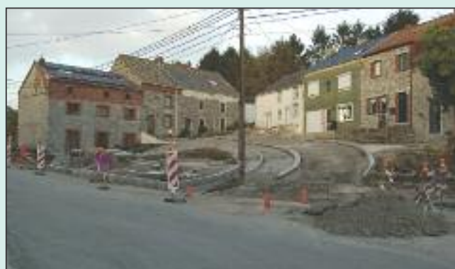
Aménagement de la place du Bâty à Villers-Poterie en cours.
