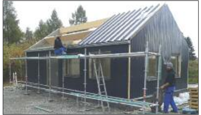
Poursuite de la construction du Chalet des Archers à Joncret.
