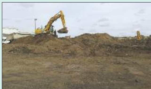
Evacuation de 3.250 tonnes de terres polluées.
