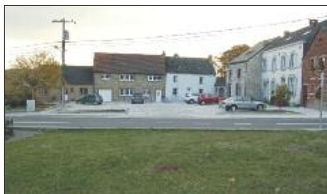
Travaux de la Place de Gougnyes presque terminés.
