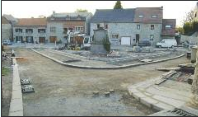
Rénovation Place du Monument à Villers-Poterie en cours.
