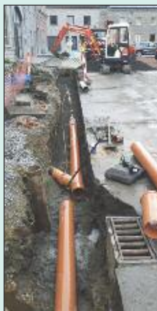
Réparation d'un tronçon d'égouttage public, Place d'Hymiee.
