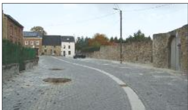
Rénovation de la Rue de l'Escuchau à Gougnyes pratiquement terminée.
