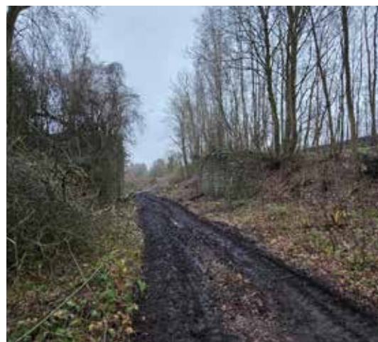
Elagage et nettoyage sur le chantier du pré-RAVel à Gougnyes.
