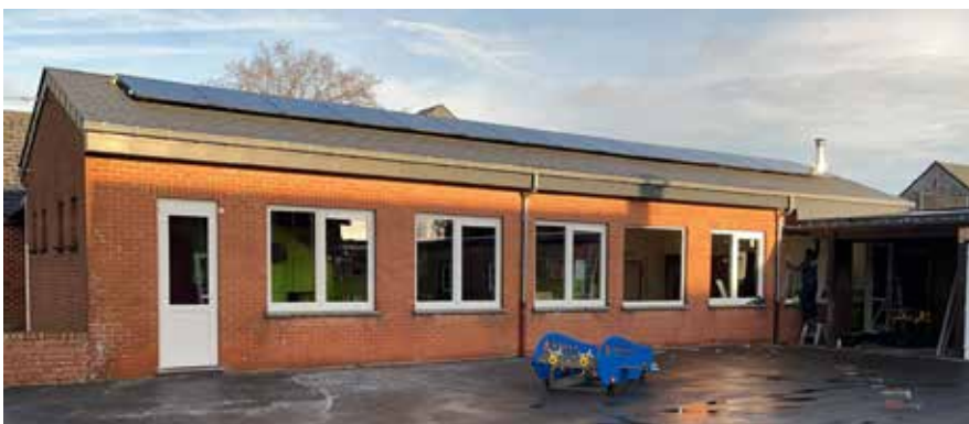
Remplacement des châssis à l'école Henri Deglume.
