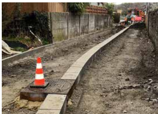
Pose d'un égout et réfection de la voirie à la rue du Phalanstère
