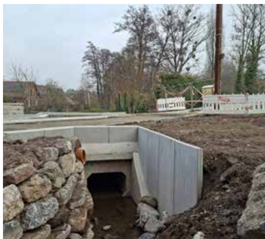
Travaux de remplacement du puits du ruisseau du Charnoy à la rue du Pré Barré.
