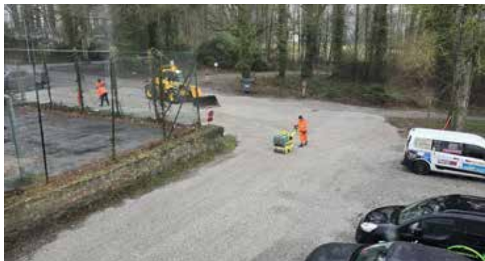
Nouvel empierrement sur le parking secondaire de la maison communale
