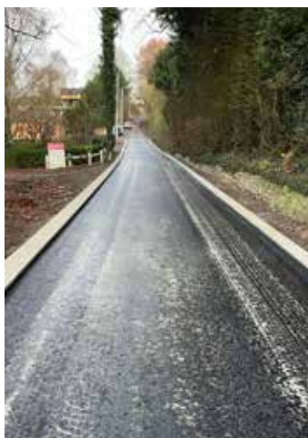
Réfection complète de la voirie à la rue des Fiestaux.
