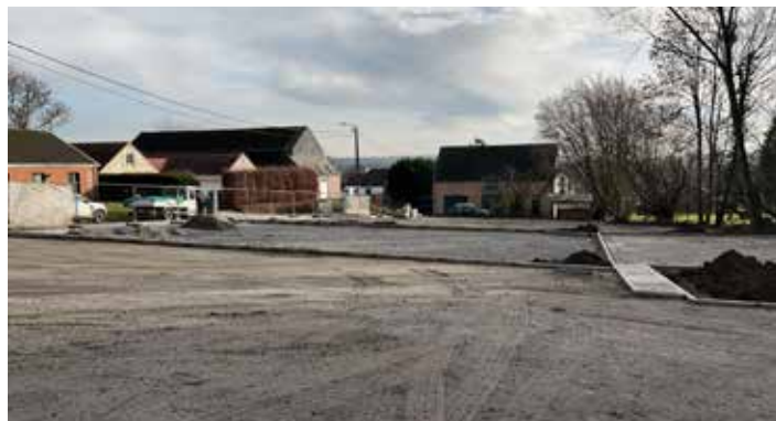
Création d'un parking et d'une aire de jeux à la rue des Guichoux
