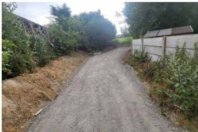
Aménagement pour la lutte contre les inondations près de la route de Florennes
