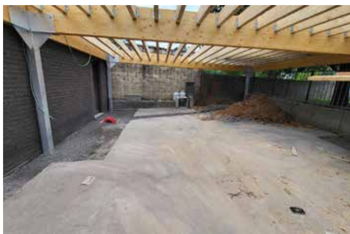
Nouveau préau à l'école de Lausprelle
