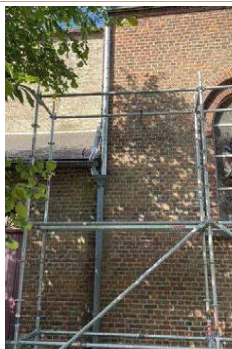
Remplacement des gouttières à l'église des Flaches
