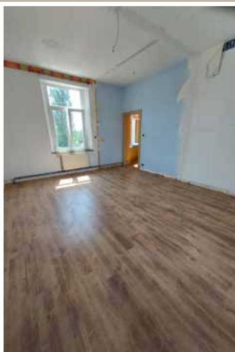
Travaux à la cure d'Hymiee
