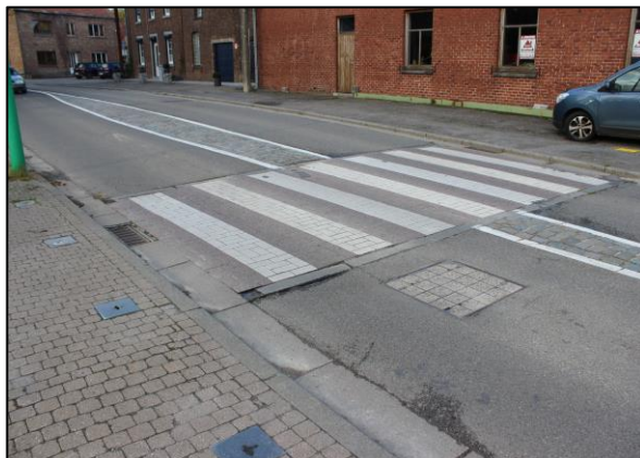
Figure 1: Passage piéton correct, mais sans aides PMR - rue de Villers à Lausprelle
