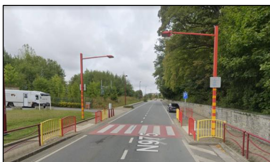
Figure 43 : Gerpennes, Avenue Reine Astrid. Traversée piétonne aménagée avec dalles de guidage et dalles d'attente (source : Google Maps)
