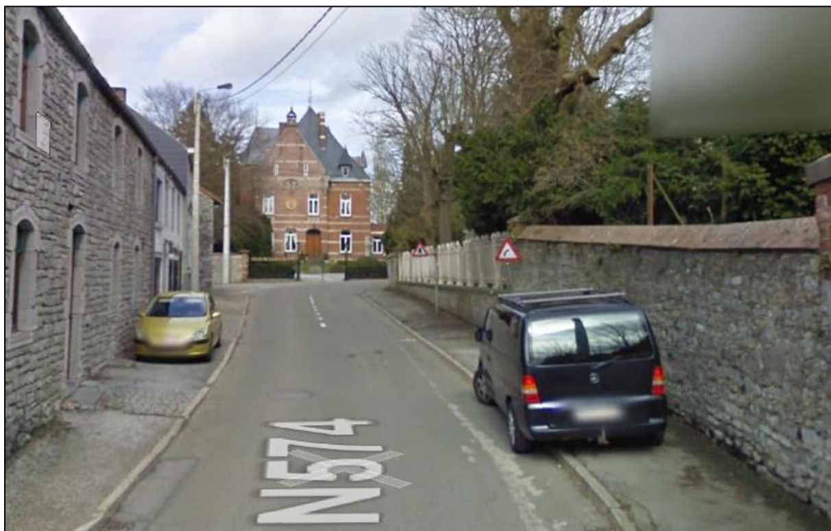
Figure 38 : Stationnement sur trottoir, rue Alfred Mangeot, village de Gerpinnes (source : Google Maps)
